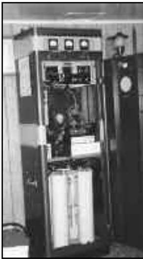
Le répéteur, le compteur d'heures, le contrôle à distance et le raccordement téléphonique
